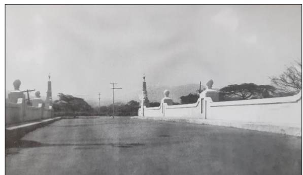
Puente de Mamatoco construido para el Centenario de la muerte de Bolívar (1930) 73
