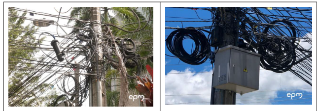
Fotografías: Enrollo de cables (EPM, 2019)
